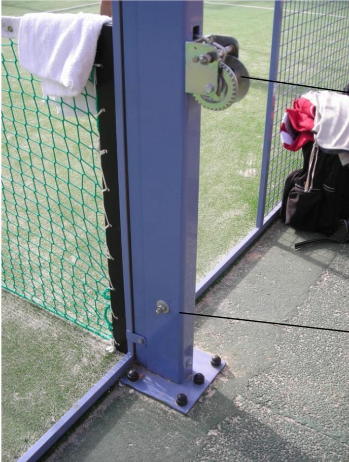
Este sistema colocado de forma exterior puede provocar accidentes graves por desgarre de los usuarios
