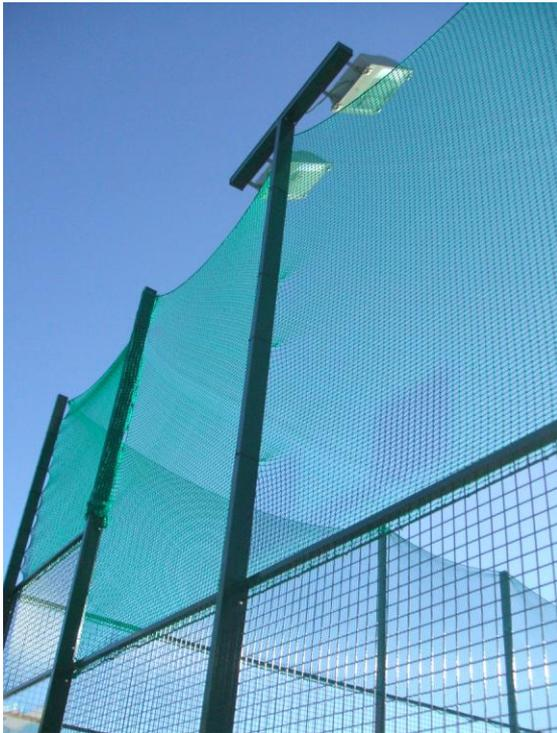
Nuestro sistema de postes tapados con por la parte superior con pieza de plástico nos permite poder quitarlo para insertar un a prolongación para soporte de iluminación o prolongación para colocación de red de nylon.
