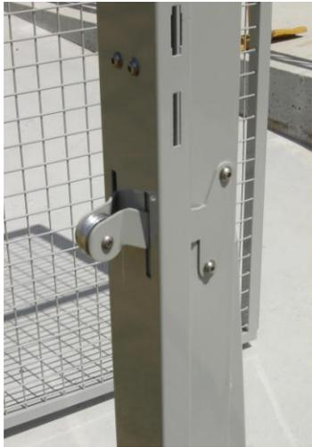
**las poleas son regulables en altura para asegurar las distancias de la red al suelo, además permiten el reparto de la tensión de la red en los cuatro puntos de cogida**
