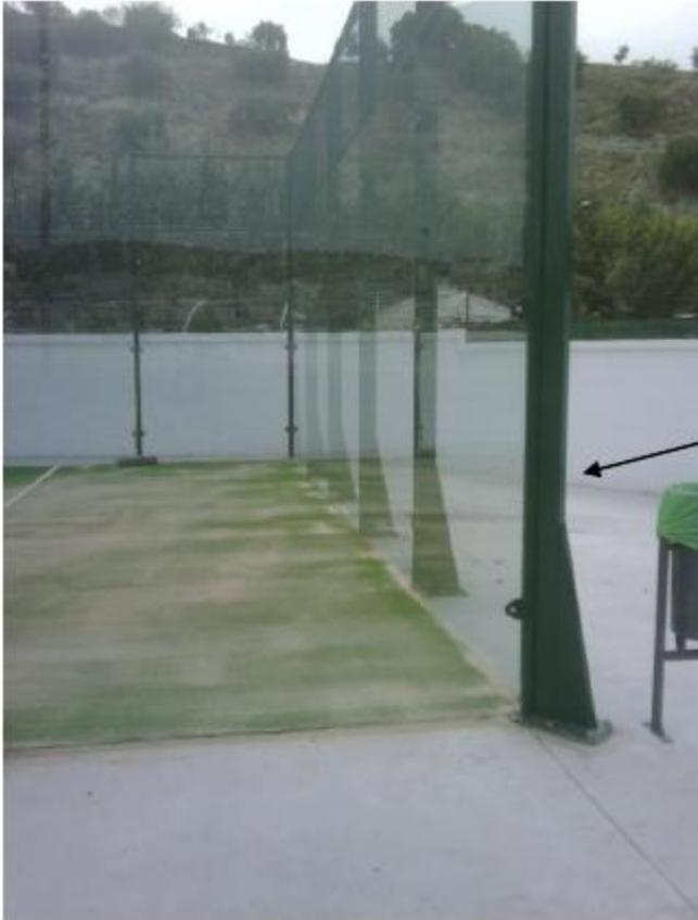
**4 pilares de esquina de 4000 mm de altura( $\pm 3$ ) compuesto de tubo de 120x60x3 con un perfil de chapa plegado de 3 mm que le da rigidez al pilar.**
